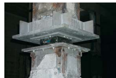
Taglio dei pilastri del Centro Polifunzionale di Soccavo Napoli per l'isperimento di isolatori ALGASISM HDRB. HDRB Base isolators for Multifunction Center in Soccavo Napoli.
