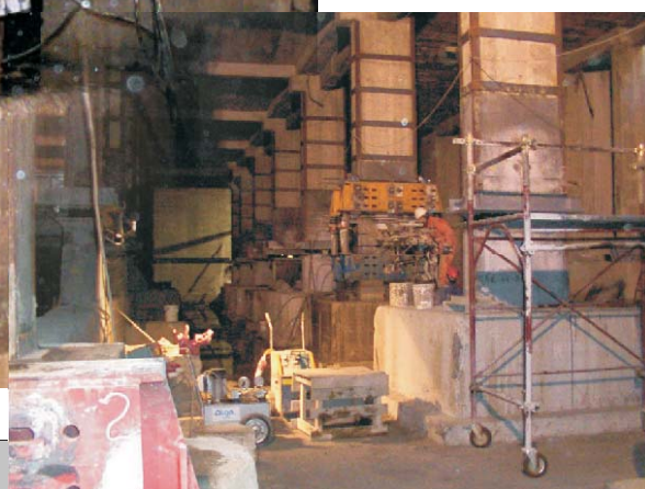
Taglio dei pilastri del Centro Polifunzionale di Soccavo Napoli per l'isperimento di isolatori ALGASISM HDRB. HDRB Base isolators for Multifunction Center in Soccavo Napoli.
